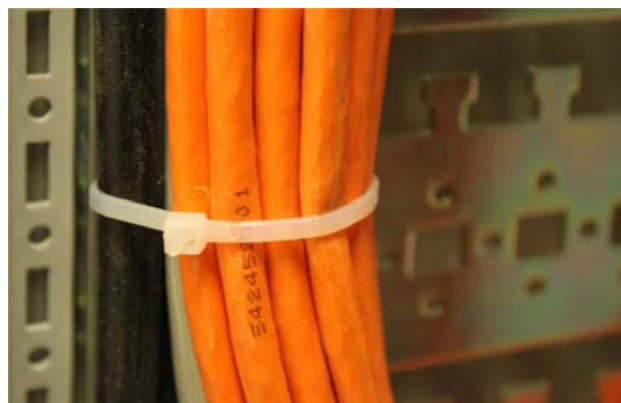
Foto 5: Door kabelbinders gekneusde kabels (bron: www.MaPaCom.EU ).
